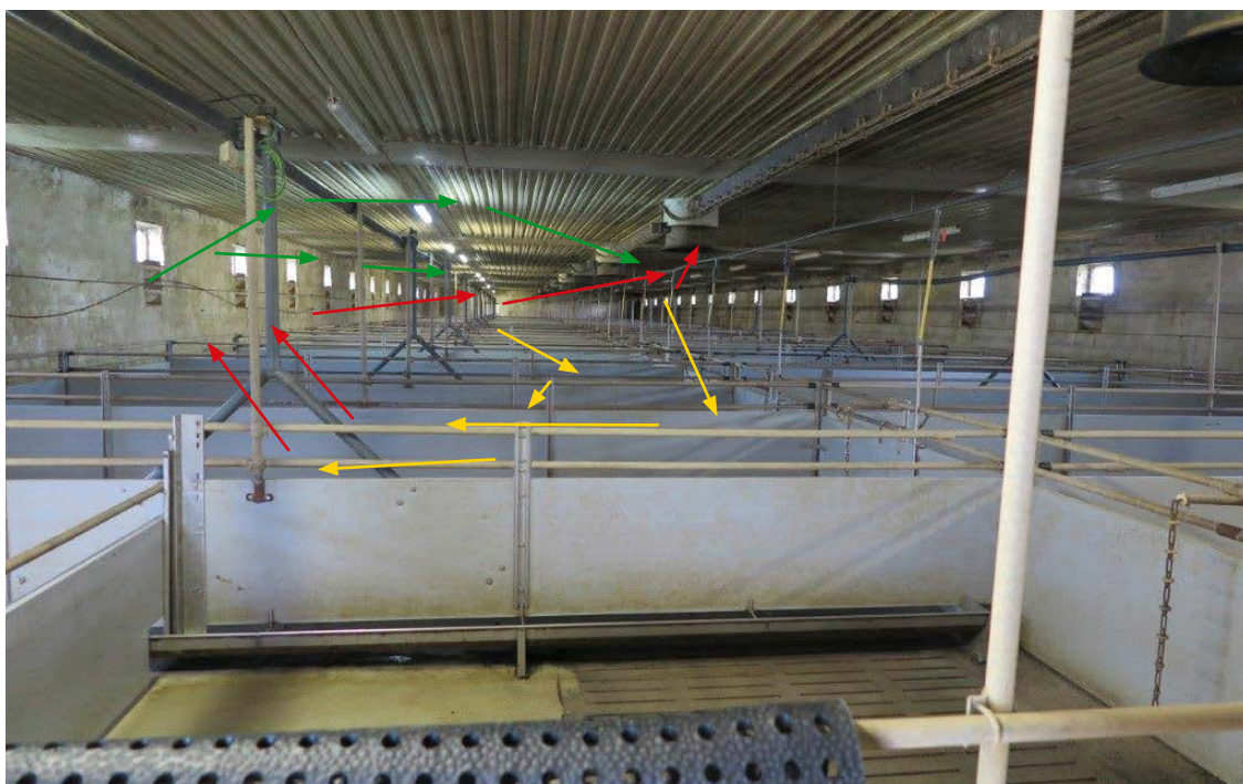
Bild 4: Halbseitige Darstellung des normalen Strömungszustandes im Maststall (Grüne Pfeile – Zuluft; Gelbe Pfeile – Teilvermischte Zuluft; Rote Pfeile – Wärmere Abluft) (© Dr. M. Böckelmann)
