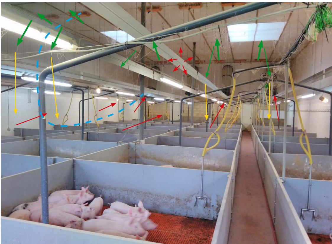
Bild 3: Ansicht der Luftströme im Ferkelaufzuchtstallteil (Grüne Pfeile – Zuluft; Sternförmige rote Pfeile – Wärmestrahlung der Twin-Rohre; Gelbe Pfeile – Erwärmte Zuluft zu den Tieren; Dunkelrote Pfeile – Abluft auf dem Weg zu den vier Abluftpunkten; Blaue Linie – Prinzipdarstellung der Luftströmwalze) (© Dr. M. Böckelmann)
