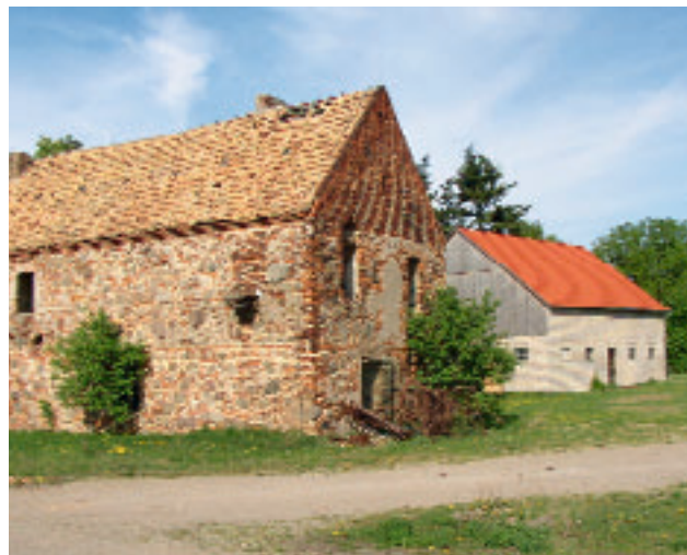
Das Gebäude der Biokelterei "Bergschäferei" (rechts) wurde mit Hilfe von Fördermitteln saniert und mit Produktionsgeräten ausgestattet.
