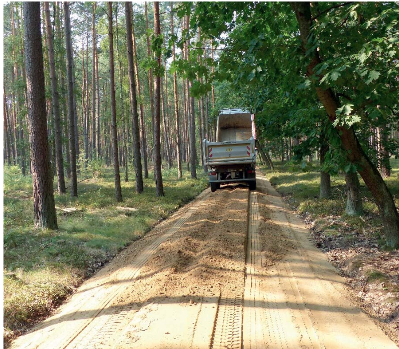
Wegebauaßnahme im Landeswald
