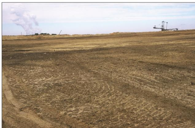
*Frisch planierte Kippe mit dem angefallenen Abraum, in den jetzt noch Kalk, Mineraldünger (Stickstoff, Phosphor, Kalium) und ggf. organische Bodenverbesserungsmittel (z.B. Biogrünkompost) eingearbeitet werden. (Bild links unten)*
