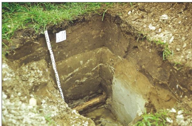
Eingebaute Drainagen beschleunigen den Wasserabfluss. (Bild links unten)
