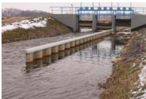
Wehr Dargardt mit FAA, Ansicht von Unterwasser
