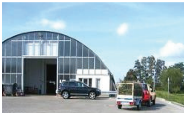
Wertstoffannahmehof der UDG mbH in Prenzlau
