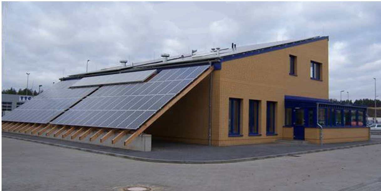
Nebenbetriebsstätte des SBAZV in Niederlehme
