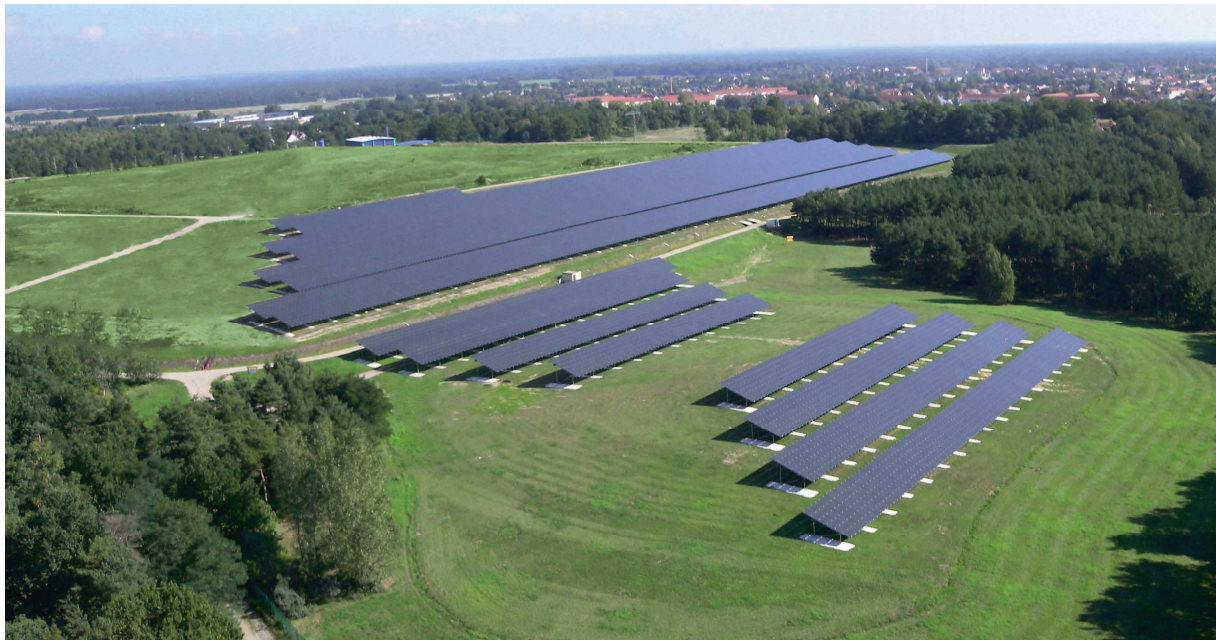
Solaranlage auf der Deponie Luckenwalde: Fläche 2,7 ha, Nennleistung > 1 MWp, Modulbauart „Dünnschichtelemente“ der Firma Nanosolar Luckenwalde
