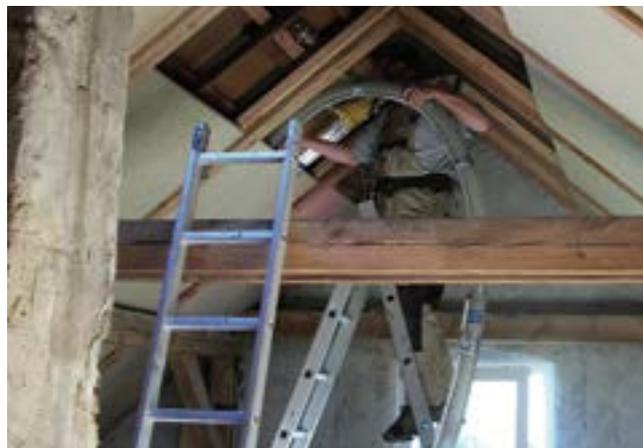
**Abbildung 13:** Der fertige Einblasdämmstoff wird in Paketen zum Einbringen durch einen Fachbetrieb zur Baustelle geliefert und verbaut.
