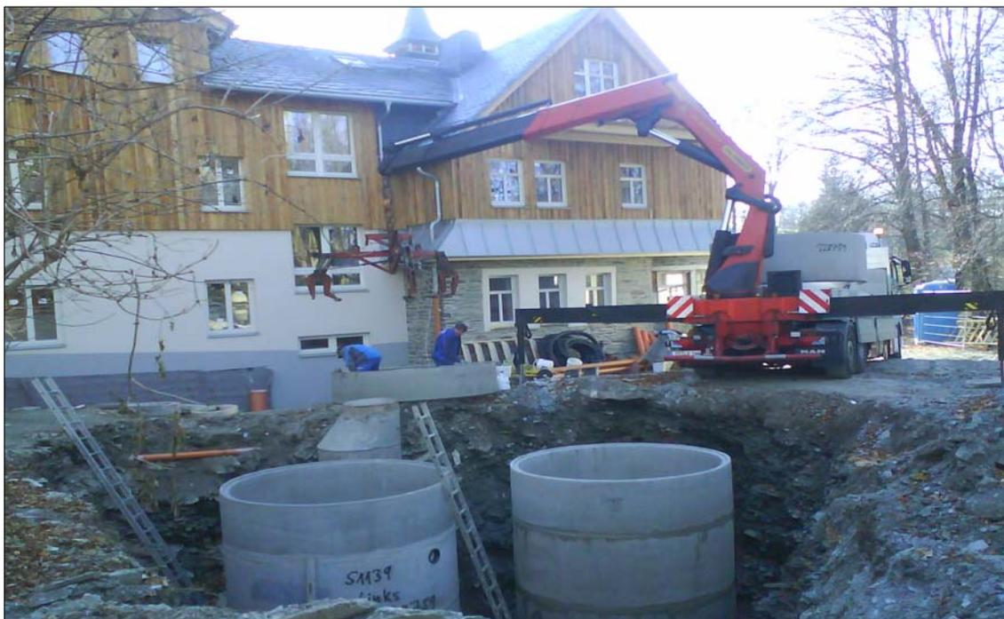
Abb. 10: Einbau einer SBR-Kleinkläranlage (sequence batch reactor, Anschlussgröße 4 – 28 EW)
