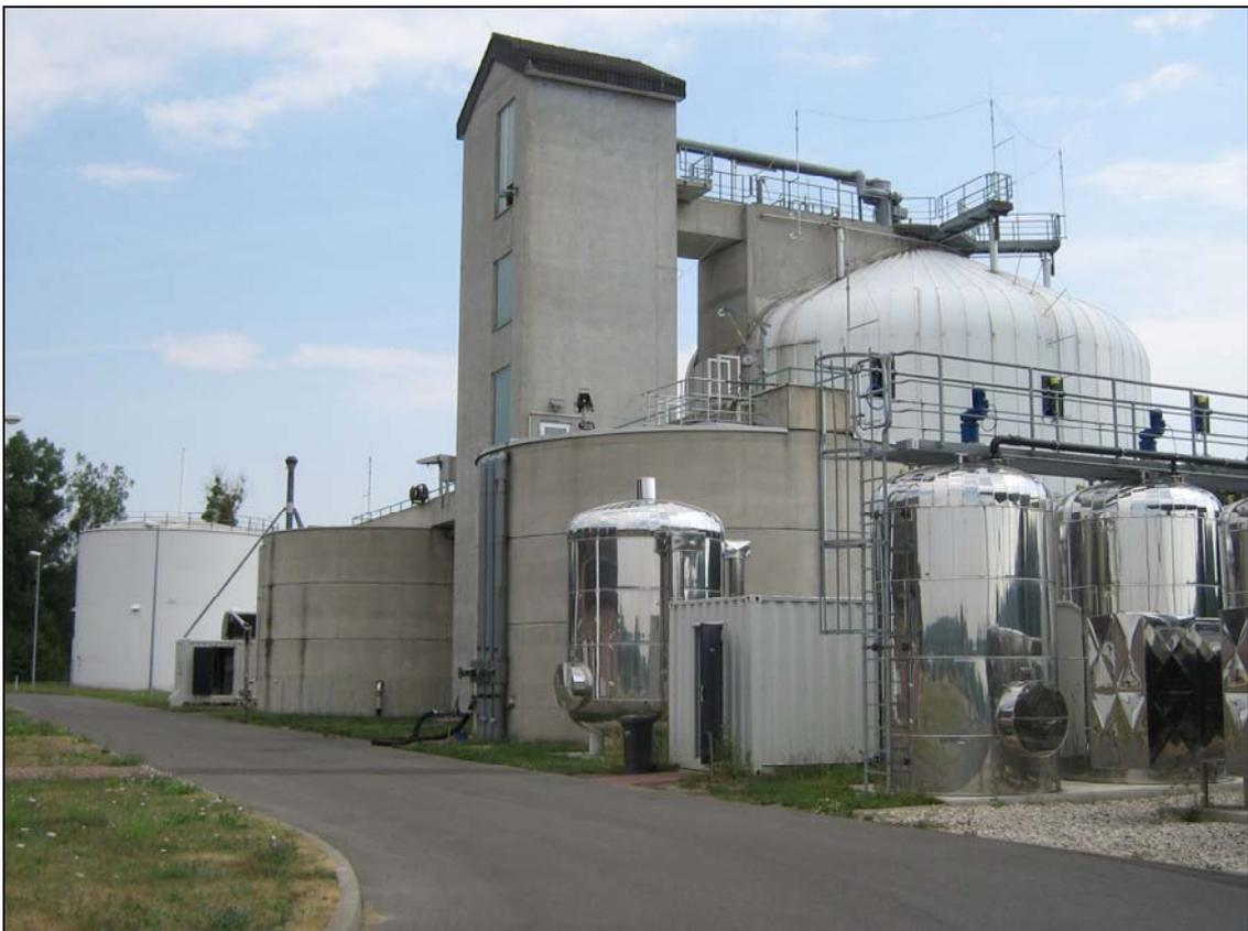
Abb. 11: Schlammspeicher, Faulturm und Aufbereitung der Fettschlämme (Co-Vergärung) der Kläranlage Brieske
