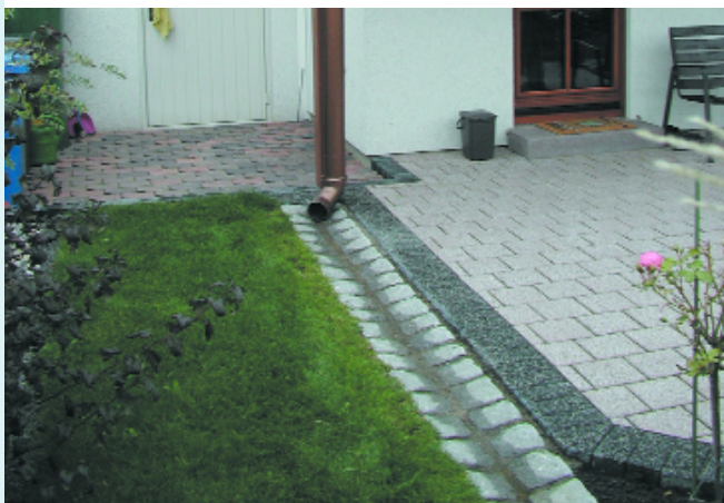
Abb. 35: Regenwasserableitung in Kastenrinnen zur Versickerung in öffentlichen Grünflächen
