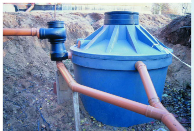
Abb. 10: Aufbau einer Regenwassernutzungsanlage
