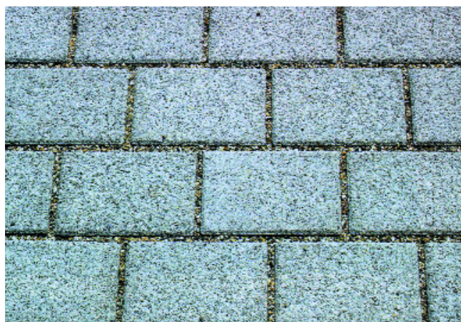
Abb. 7: Aufbau Rasenfugenpflaster
