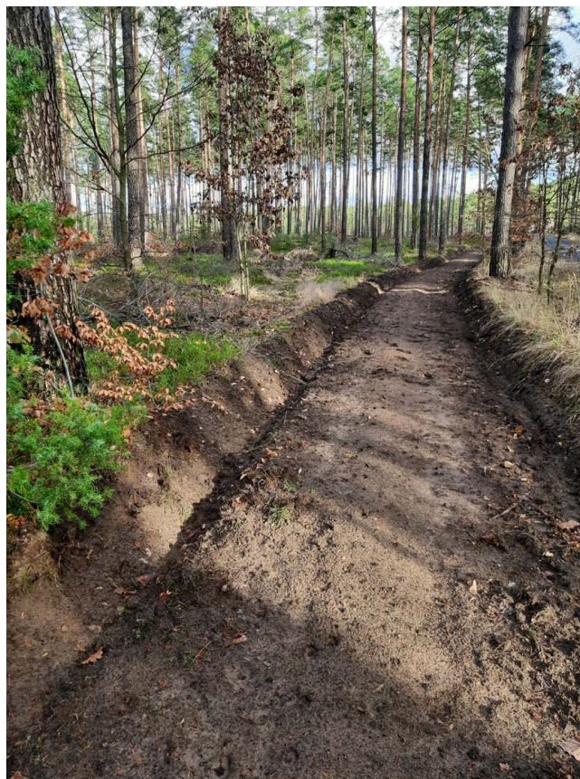
Abb. 3: Waldbrandschutzstreifen entlang von Straßen und Wegen sollen das Übergeifen von Feuer in den Wald verhindern (Foto: J. Engel)
