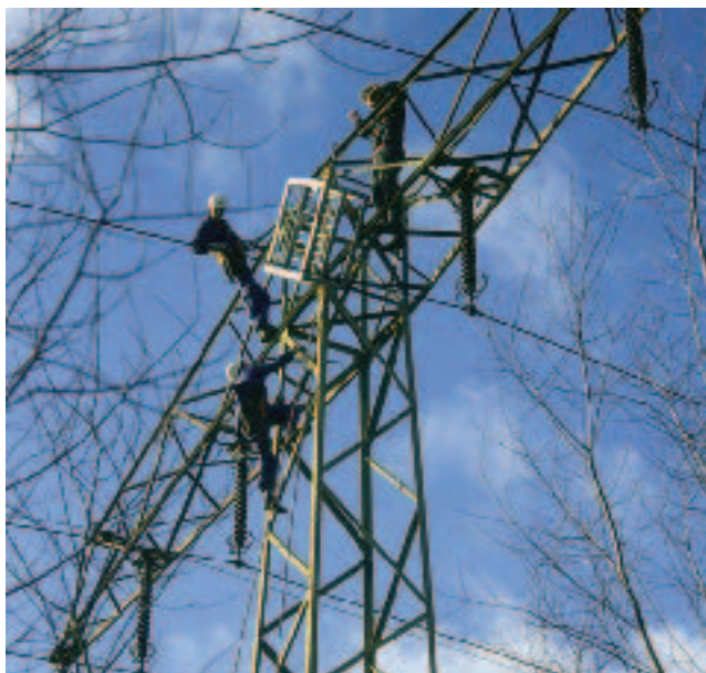
Anbringung eines Kunsthorstes durch Mitarbeiter des Energieunternehmens Foto: Ilona Damm
